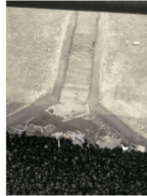
图4 土路肩汇流口
