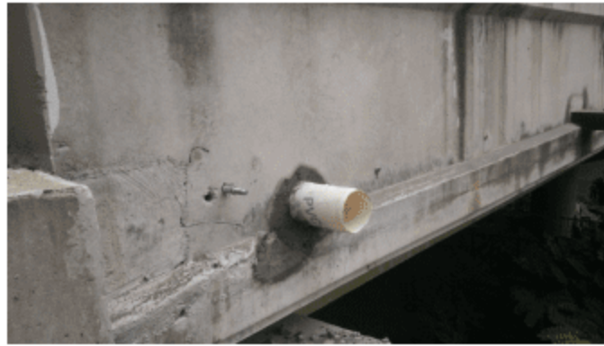
图5 伸缩缝与墙式护栏交接处泄水口
